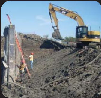
Almedia/Walker LPV07d.2, USACE
